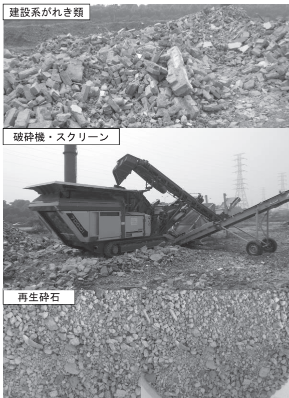
写真1 ベトナムにおける再生砕石製造状況 (2019. 8)
